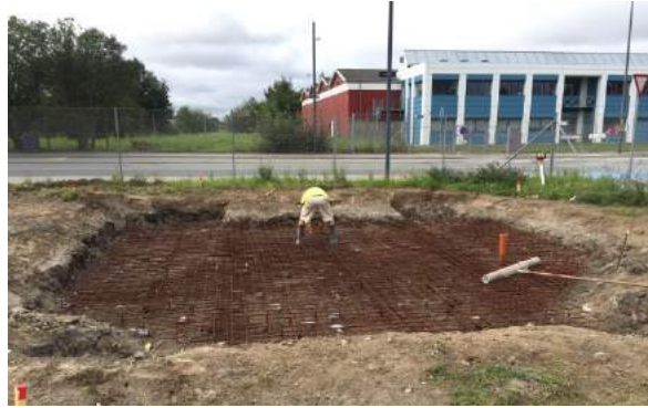
Pilotering og armering af fundament
