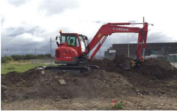
Forberedelse af fundament og pilotering
