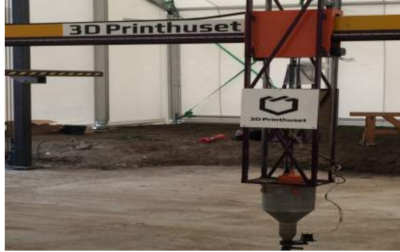
3D print af øverste del/randen af fundamentet
