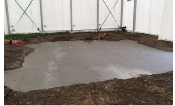
Udstøbning af basis fundament
