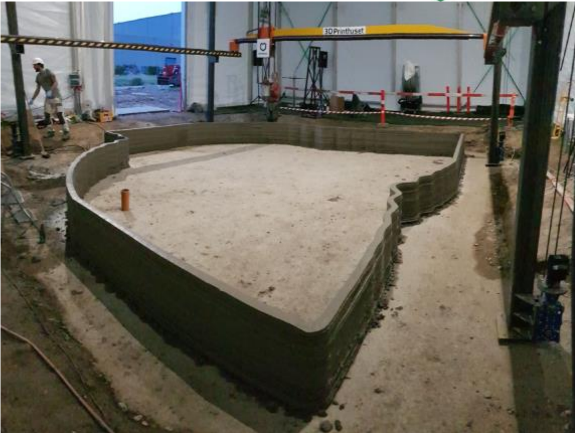
Færdigt randfundament efter få timers 3D printning
