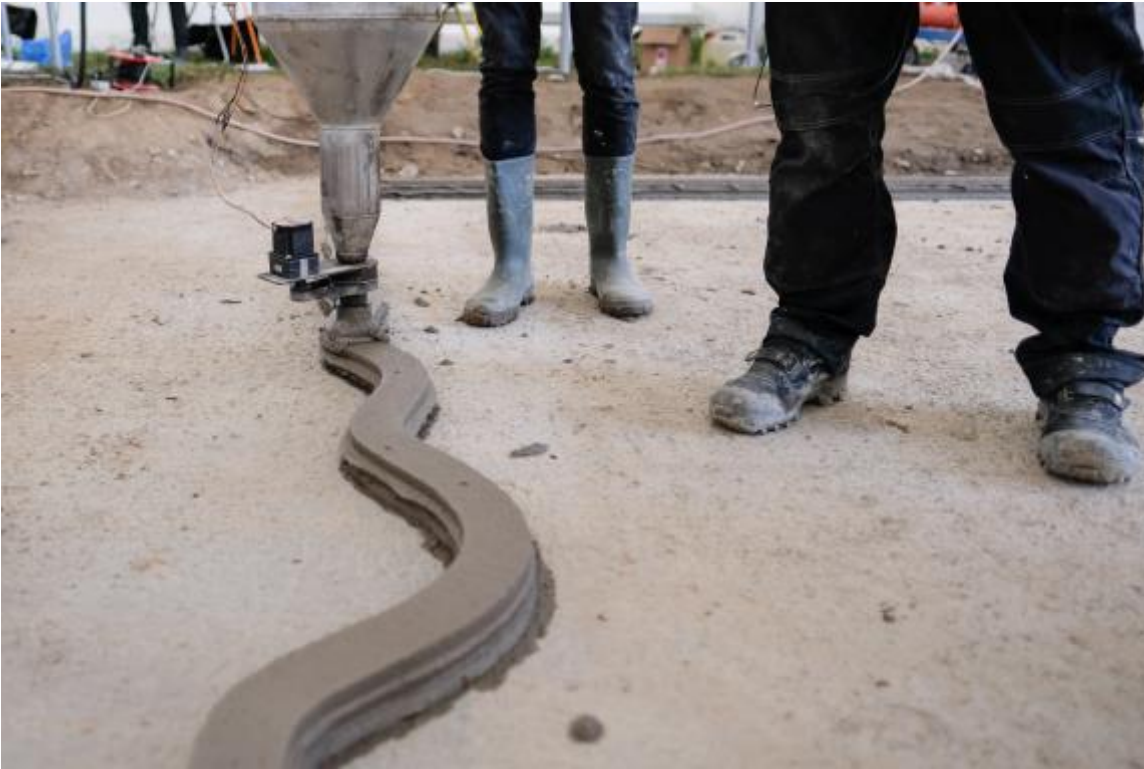
Starten på 3D printning af randfundamentet
